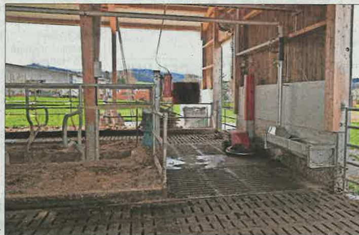
Im Laufstall gibt es keine Stufen. Zwei Drittel der Fläche ist Spaltenboden mit Gummibelag, der Rest ist betoniert.
