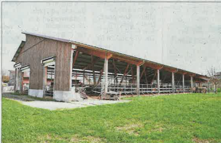
Der Blick von der Obstplantage her ist direkt auf die Kühe gerichtet. Der Stall ist südseitig komplett offen.
